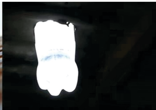
Hình 3. Giải pháp chiếu sáng ban ngày bằng chai nước [11]
